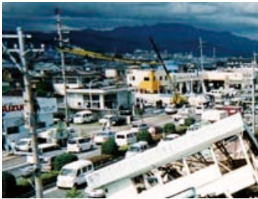
[写真5] 2006年9月17日、台風13号に伴う竜巻が延岡市街を襲い、倒壊した家屋
