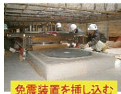
[写真 3] 京都大学時計台の免震改修
