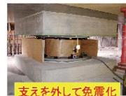
支えを外して免震化
