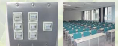
照明スイッチ(ゾーン分) 教室の部分点灯
