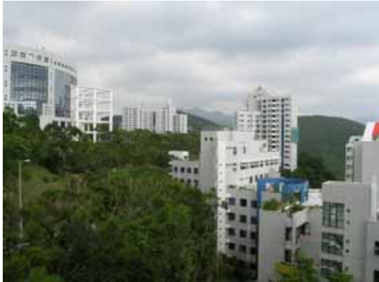
写真: 斜面に建つ施設群
