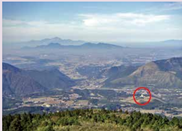
草千里展望台から西を望む。火山活動や地震活動によって形成された圧巻の地形が目に飛び込んでくる。○で囲まれたのがセンターの建物。
